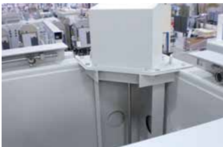
Carga de gas de protección sobre el borde contra incendios
