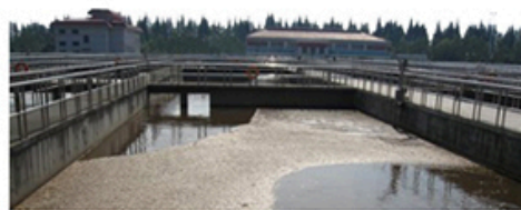
Centro de tratamiento de aguas residuales
