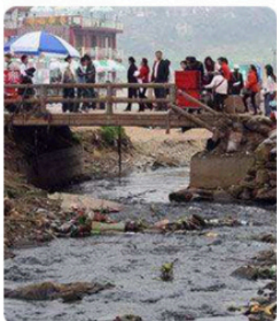
Aguas residuales domésticas
